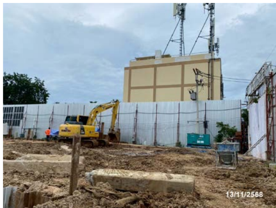
รูปที่ 2-4 การเปิดหน้าดิน/การปรับระดับหน้าดินให้แน่น
