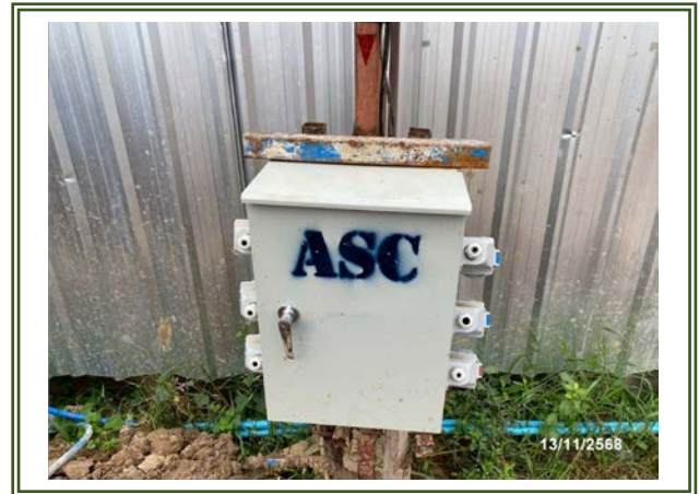
รูปที่ 2-30 แผงควบคุมไฟ
